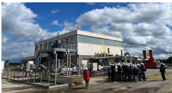
La centrale de géothermie à Rittershoffen (Bas-Rhin)
