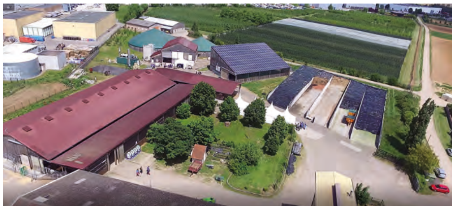
Exploitation agricole et unité de méthanisation de l'établissement d'Obernai
